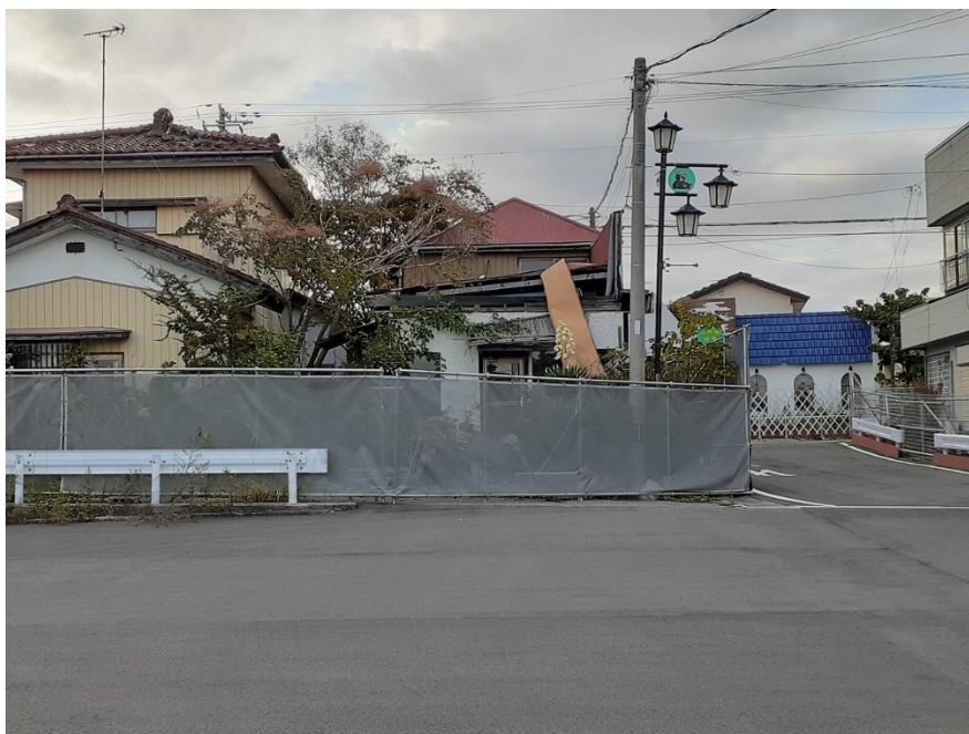
バリケードに囲まれた駅前の住宅地
