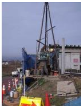
詳細調査 (ボーリング)
