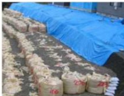
応急対策 (土留工)
